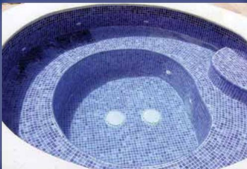
**4** Nunca se debe instalar una coladera de drenaje en sustitución de un dren de fondo ya que no están diseñadas para tal efecto. Los drenes no son coladeras, son elementos del sistema de succión y filtraje y deben guardar ciertas características de seguridad, resistencia, eficiencia y materiales de fabricación.
