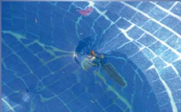
**2** Cuando se calculan mal los sistemas de bombeo y/o los drenes de fondo o por bajar costos, se realiza una instalación IRRESPONSABLE, sin los equipos adecuados o de funcionamiento deficiente, se pueden generar problemas muy graves de seguridad en la piscina haciendo de ésta una trampa mortal para los usuarios, como podemos apreciar en la foto en donde se genera un remolino de una fuerza suficiente como para ahogar a cualquier adulto. Imagínate a un niño.
