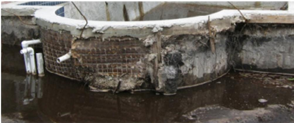
Para evitar que la presión hidrostática tenga este efecto en nuestra instalación, es necesario colocar una válvula que permita liberar la fuerza ejercida por el manto freático; para piscinas elevadas, o instaladas en edificios, no es necesario colocar esta válvula ya que los mantos freáticos no afectan la instalación.
